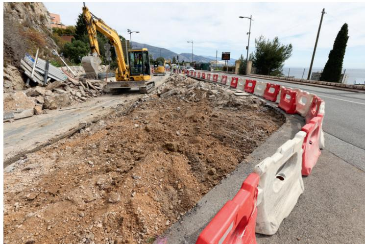
Les réseaux d'eau usée vieux de plus de 70 ans sont remplacés jusqu'au milieu de l'avenue de Verdun. Un réseau d'eau pluviale est également créé sur cette même section pour protéger les habitants et les usagers de la voie publique.
